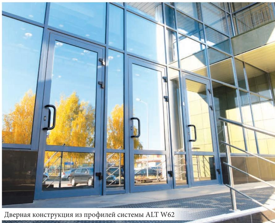
Дверная конструкция из профилей системы ALT W62
