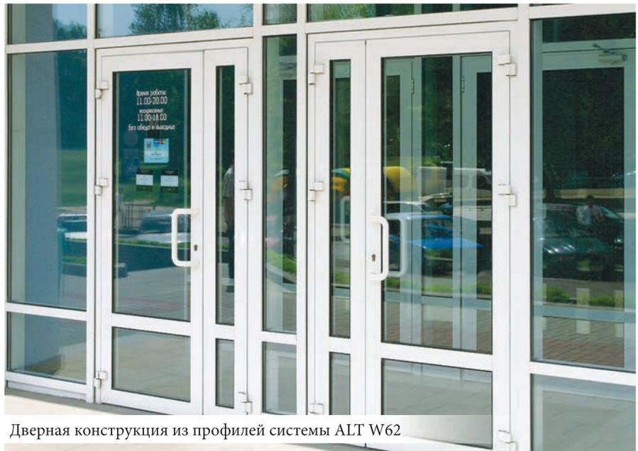
Дверная конструкция из профилей системы ALT W62
