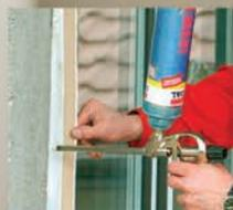
Полиуретановая пена Soudafoam обеспечивает надёжную тепло- и звукоизоляцию помещения
