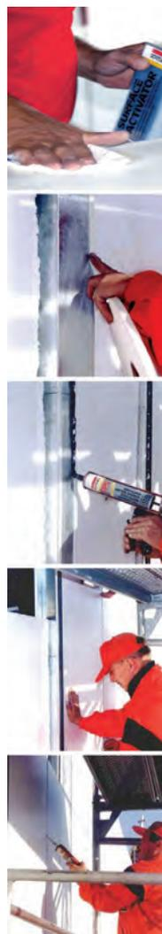
1. Очистить и обезжирить поверхность стеновых панелей от загрязнений с помощью SPS Cleaner и SPS Activator. При необходимости загрунтовать приклеиваемую поверхность SPS Primer.
