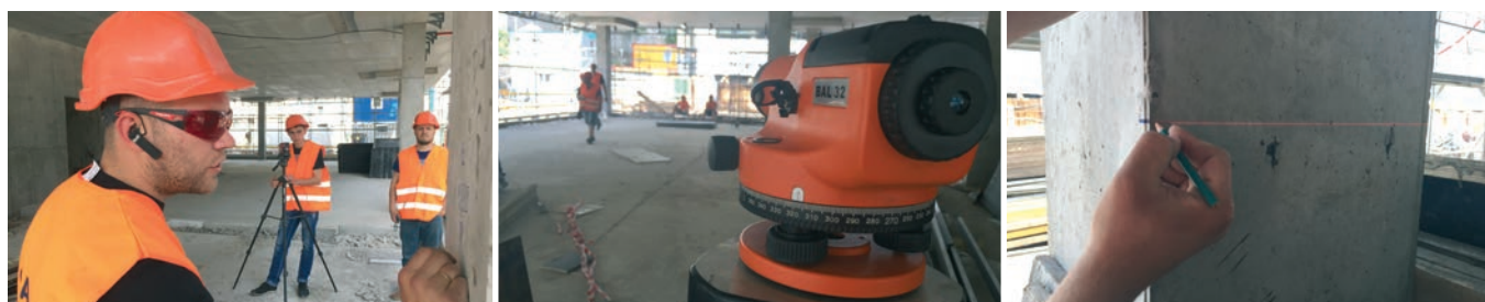
Процесс замера для составления проекта и последующего монтажа
