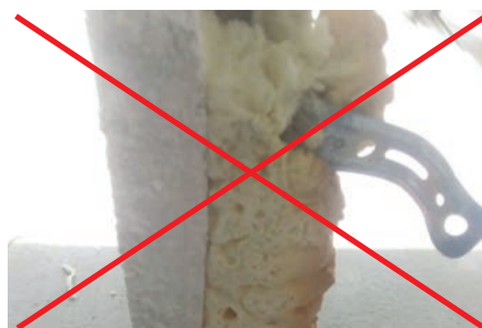
Неправильный (слева) и правильный (справа) крепежный элемент
