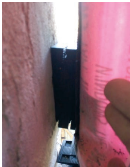
Использование опорных клиньев
