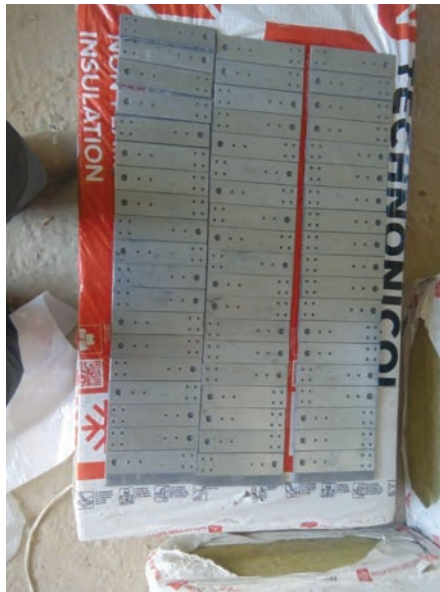
Антикоррозийная установка стального крепежа
