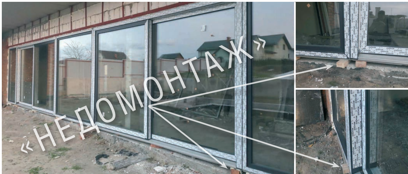
Пример неправильного монтажа
