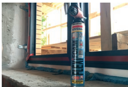
Защита монтажного узла от промерзания
