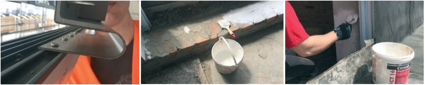
Подготовка и обработка проема перед устройством монтажного узла
